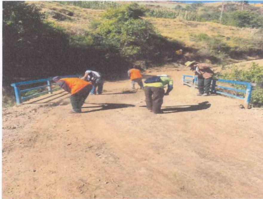
*SE OBSERVA AL PERSONAL OBRERO DEL SERVICIO REALIZANDO LA LIMPIEZA DE MATERIAL DE AFIRMADO EN EL PUENTE EXISTENTE DEL TRAMO CHIÑAC – SANTIAGO.*
